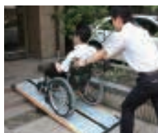
家屋周辺の段差解消
